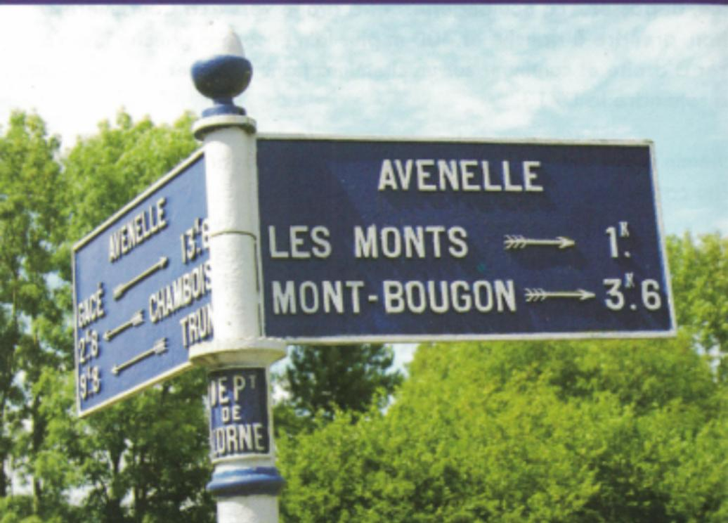
Les bornes cavalières appelées aussi « plaques de cocher » furent installées au bord des routes et aux carrefours entre 1835 et 1914, elles indiquaient les directions et les distances. Elles sont en fonte, le fond peint en bleu et lettres blanches et placées sur un mât de façon à être lisible à cheval.
